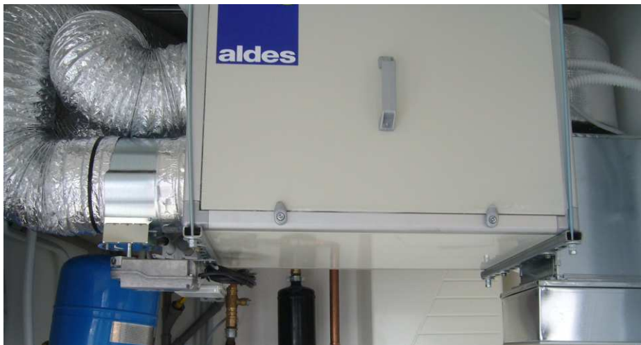
Ventilazione meccanica (portata massima 470 \text{ m}^3/\text{h} ) con recuperatore di calore ( >90\% )
