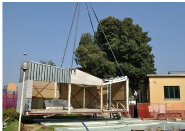
VeluxLAB: inizio del cantiere
